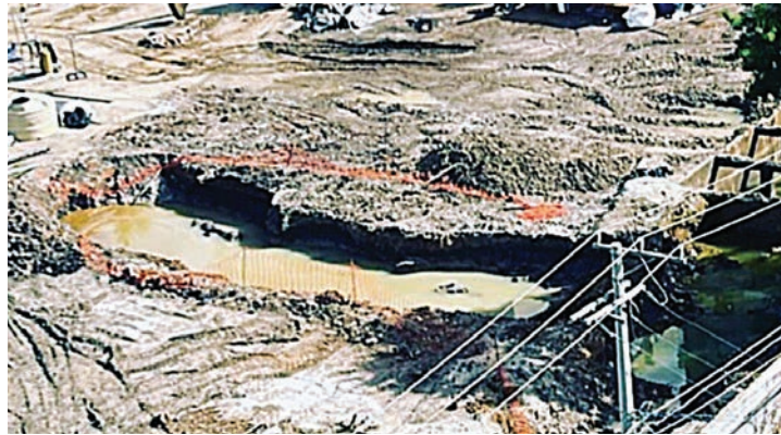
Terreno está em fase final de descontaminação
